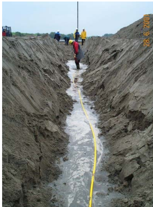
Abb. 2: einfache Verlegung der Messlinie
